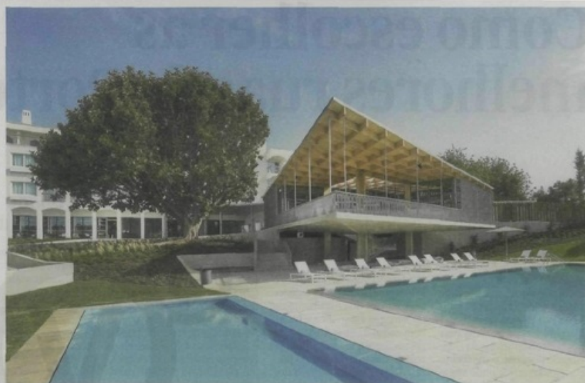
A obra do hotel, assegurada pela construtora Alves Ribeiro, demorou cerca de um ano a concluir
